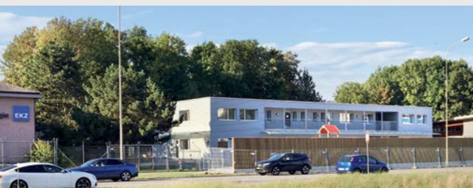
Die neue Asylunterkunft steht neben dem Werkhof Schlieren und wurde ab Oktober 2016 gestaffelt bezogen. Sie beherbergt 58 Asylsuchende.
